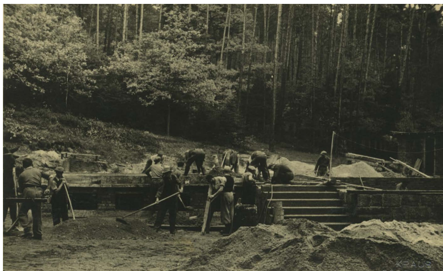
Dobrovolný pracovní tábor v Podmoklech. Výstavba studentské ubytovny, dnes budova ředitelství zoologické zahrady. Podzim 1934
